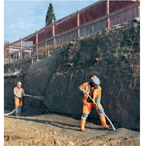
Mikrorühlwand wird mit Spritzbeton gesichert
