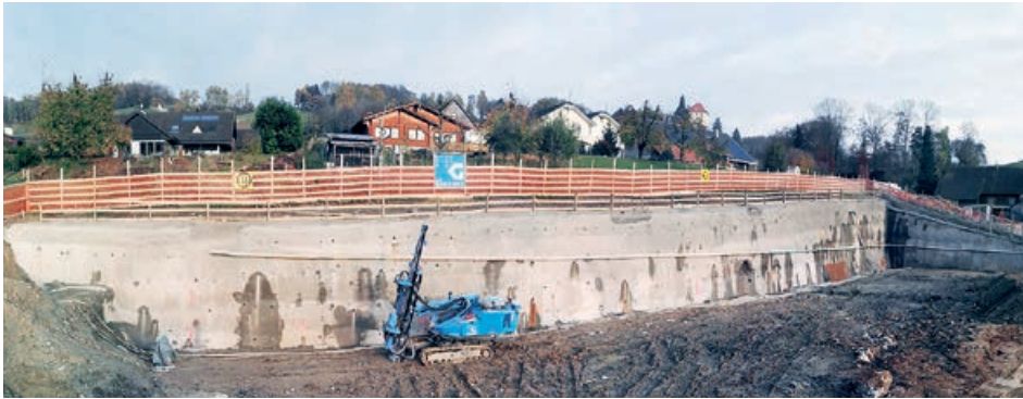
Temporäre Nagelwand kurz vor der Fertigstellung
