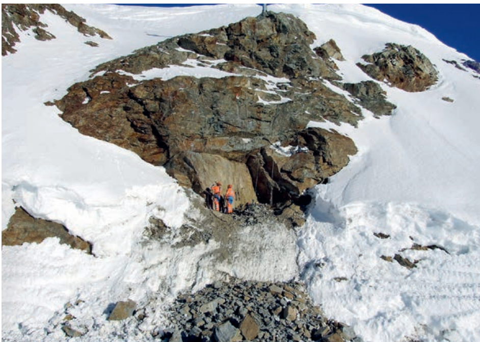
Sanierungsbereich nach durchgeführtem Felsabtrag
