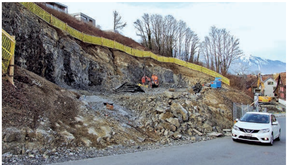
Baugrube direkt an der Quartierstrasse Räfiserhalde mit viel Verkehr und dem Schulweg der Kinder
