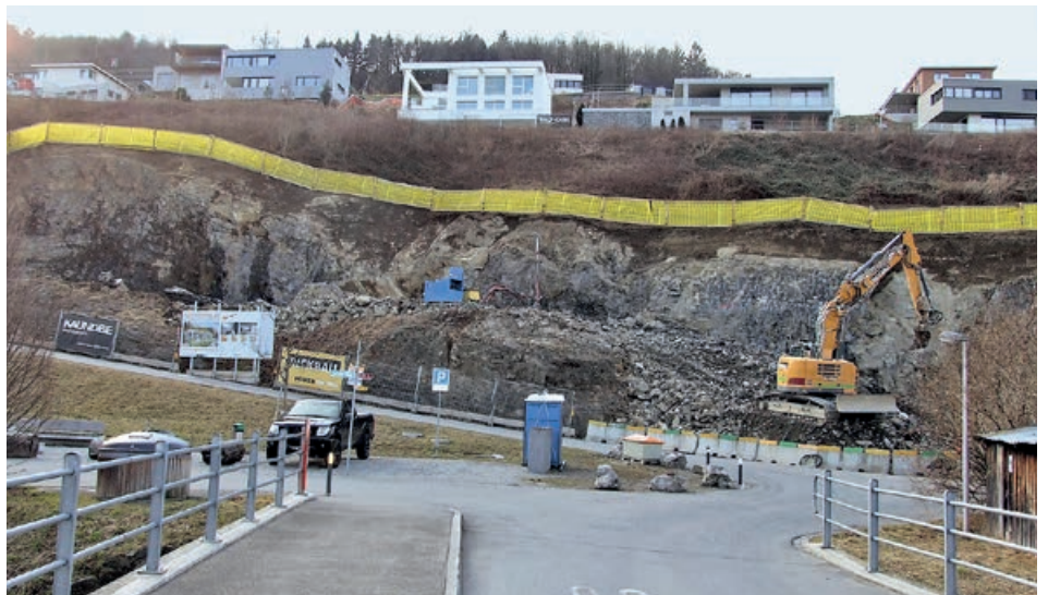
Gesamtansicht der Baugrube
