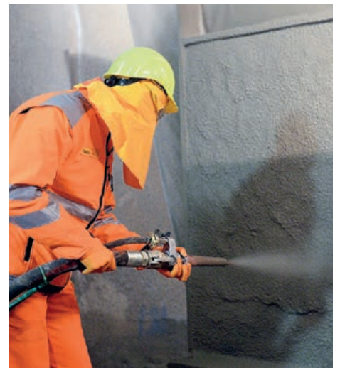
Spritzbetonversuche an Elementen
