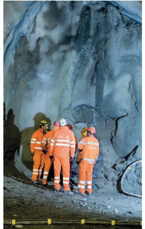
Spritzbetonversuche am Fels
