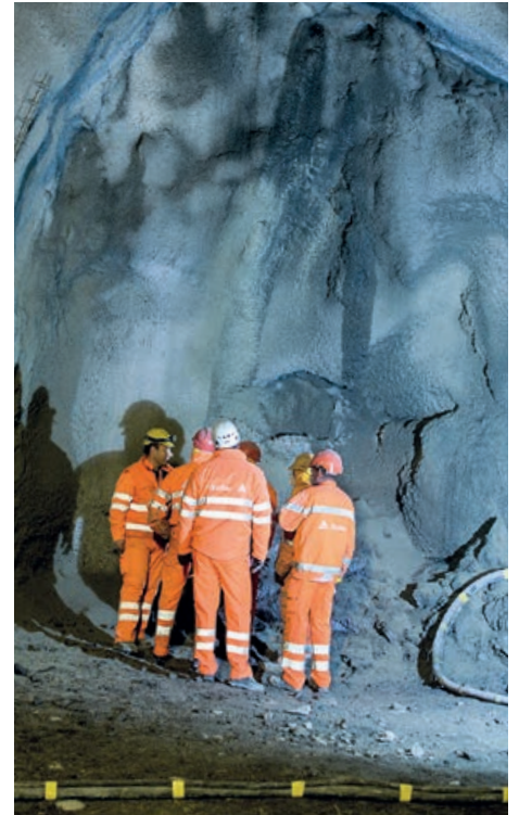
Spritzbetonversuche am Fels
