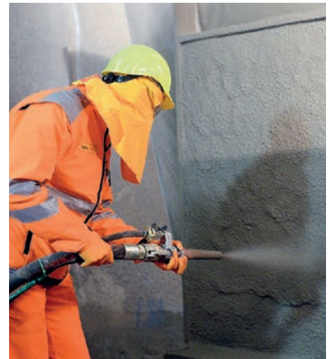
Spritzbetonversuche an Elementen
