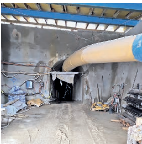
Zone couverte du portique
