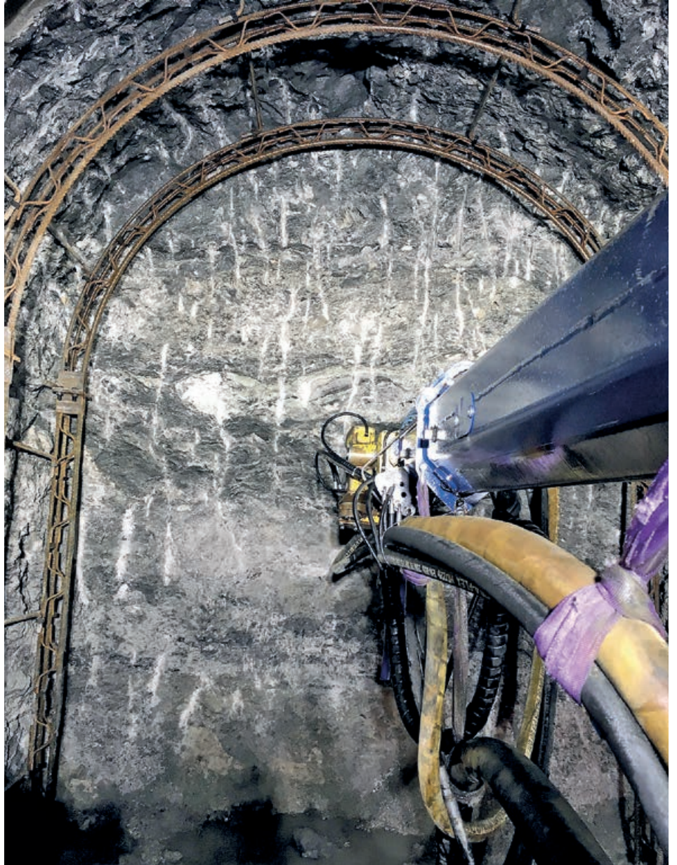
Sécurisation avec cintres
