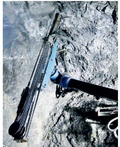
Bohren der Sprenglöcher
