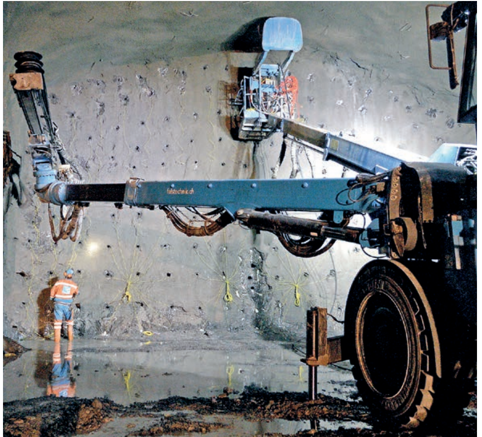
Vorbereitungsarbeiten für die Sektorensprengung
