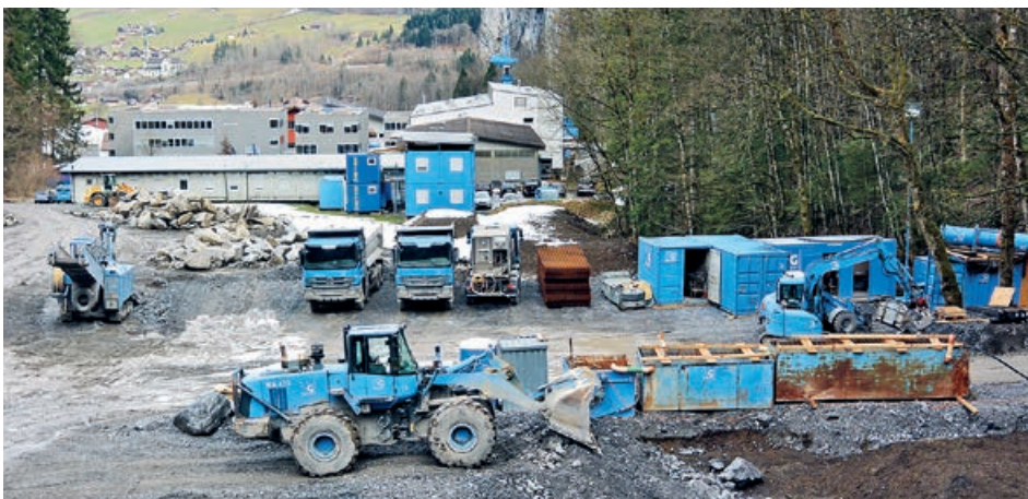
Installationsplatz oberhalb des Firmensitzes der Gasser Felstechnik AG
