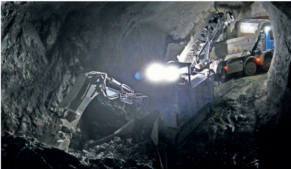
Die Sprengung ist geglückt, die Sprengschwaden entflohen, anschliessend kommt die Tunnellademaschine zum Einsatz
