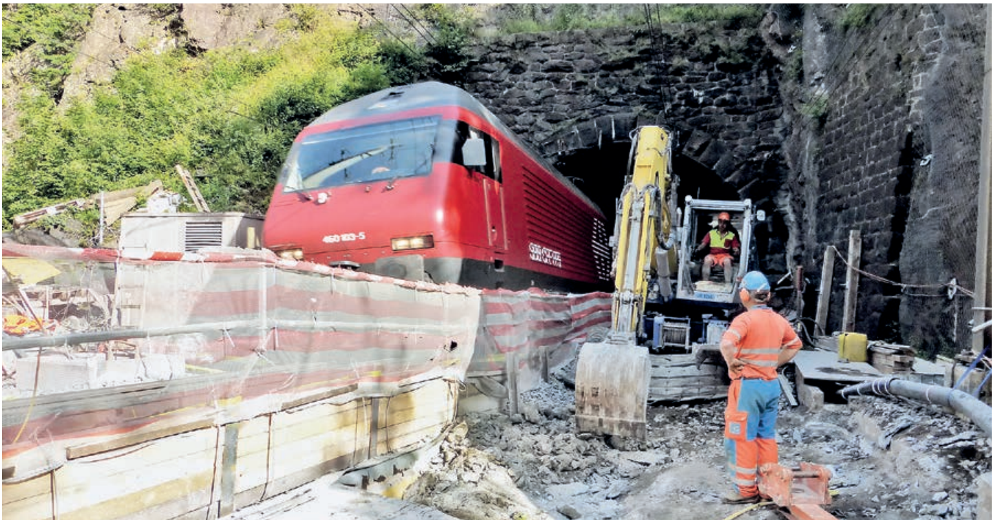
Ausbruch Schacht / Sprengungen während Zugspausen auf der Gotthardlinie
