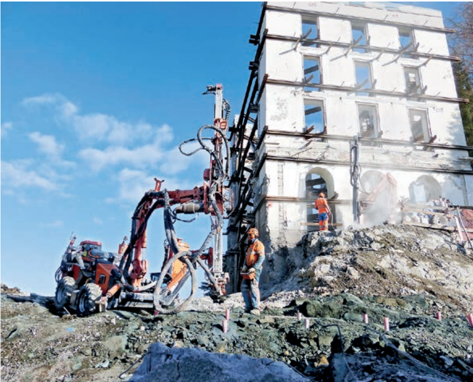
Was doch alles mit Sprengtechnik möglich ist
