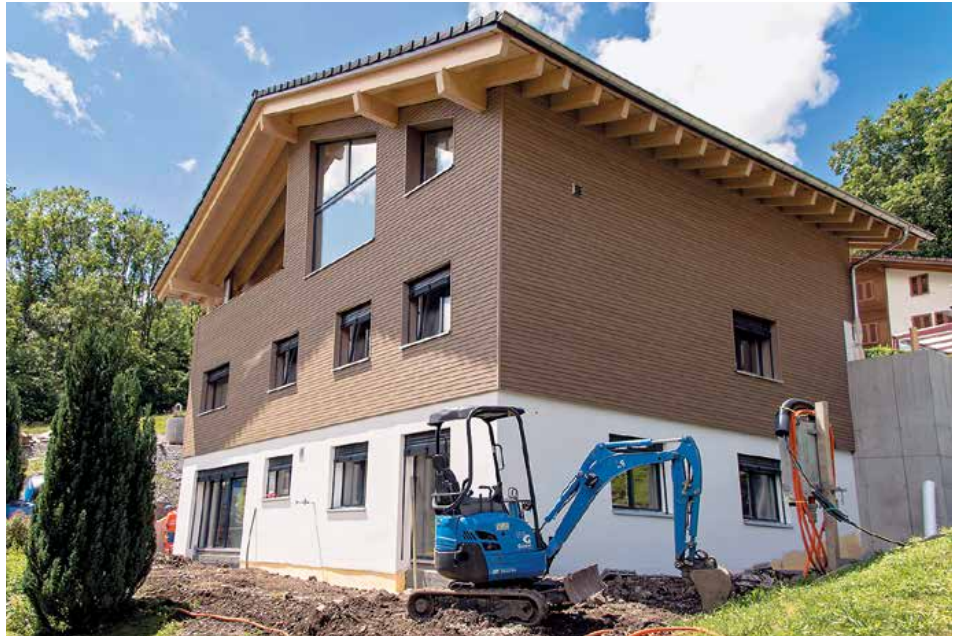
Als letzter Schliff folgten die Umgebungsarbeiten beim Wohnhaus Amstalden
