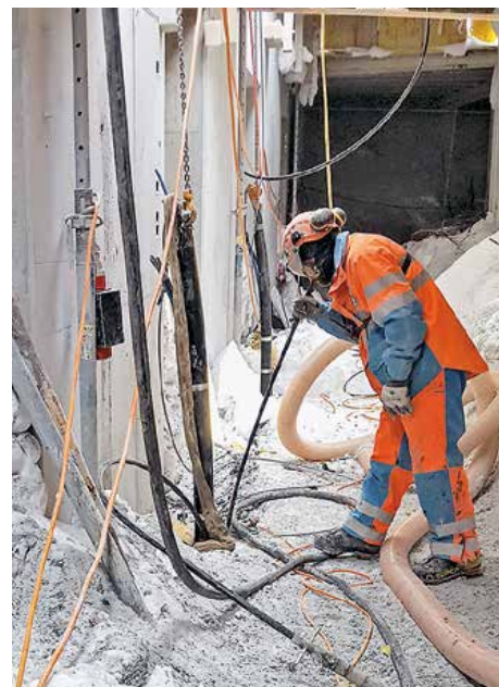
Ausseninjektion der Anker, kurz nach dem Versetzen
