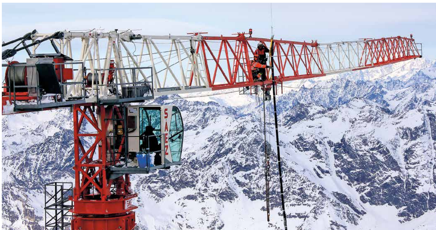
Anflug eines Ankers per Helikopter der Air Zermatt, welcher für die Versetzung an den Kran gehängt wird
