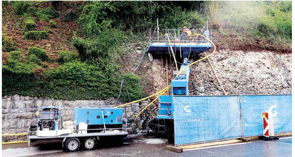
Hebebühne mit zwei Leichtbohrlafetten, die Aggregate werden nachgezogen
