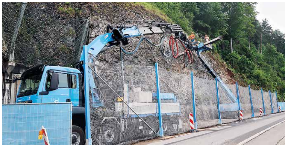
Bohrarbeiten mit dem Bohr-LKW
