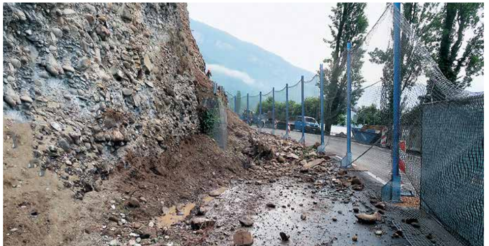
Felsreinigung oberhalb des 4 m Schutzzaunes
