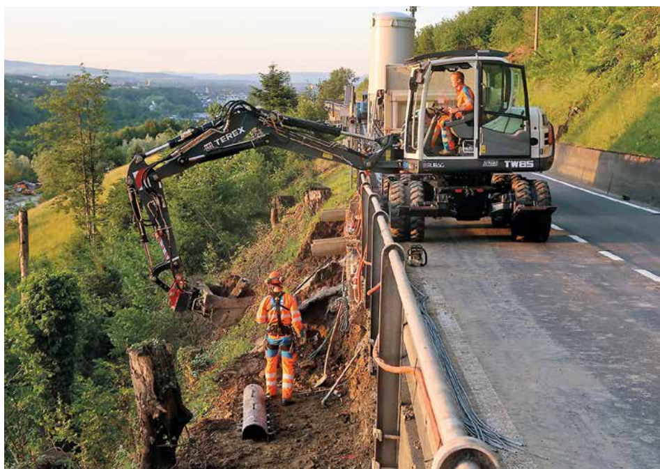
Aushubarbeiten unterhalb der Strasse
