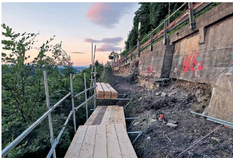
Gerüstbretter bereit zum Verlegen des Gerüstbodens
