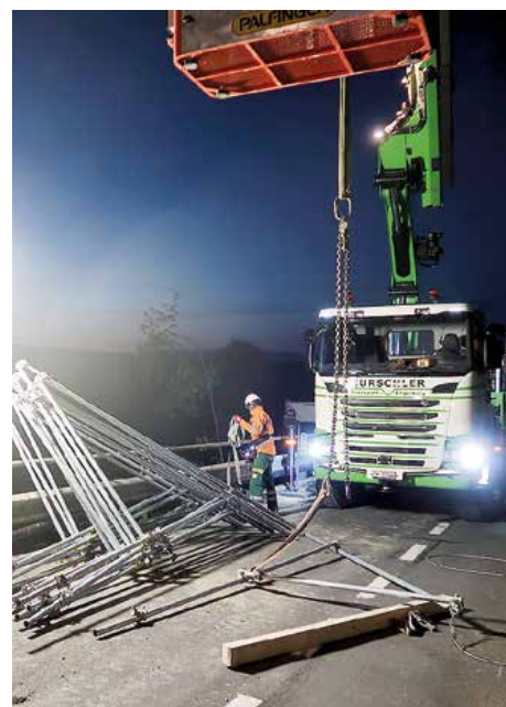
Gerüstelemente werden mit LKW-Kran versetzt
