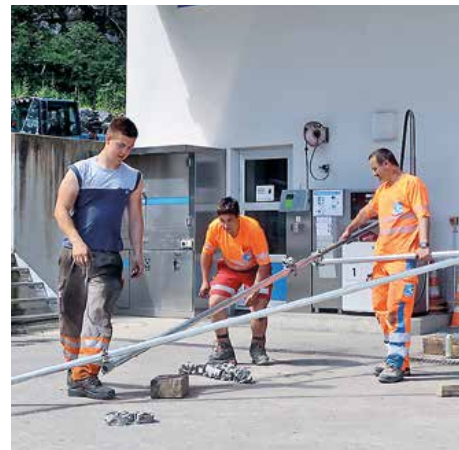
Vormontage der Gerüst-Tragelemente
