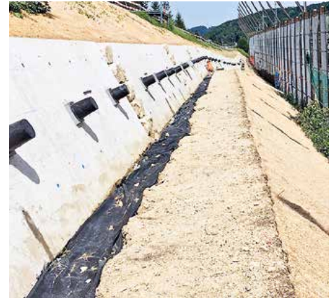
Neue Ankerwiderlager kurz vor der Fertigstellung
