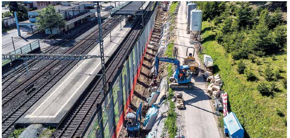
Böschungssicherung direkt an der Bahnlinie
