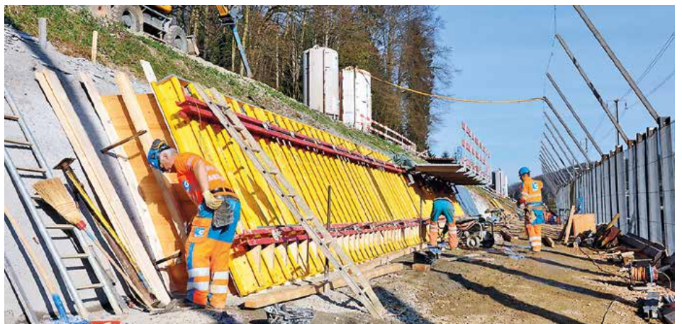
Schalarbeiten an den geeigneten Ankerwiderlagern
