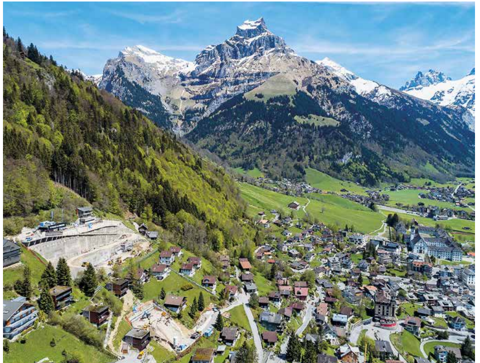
Über dem Klosterdorf Engelberg thront die Baugrube der Falkenvillen
