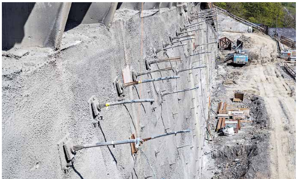
Fertig erstellte Baugrubensicherung
