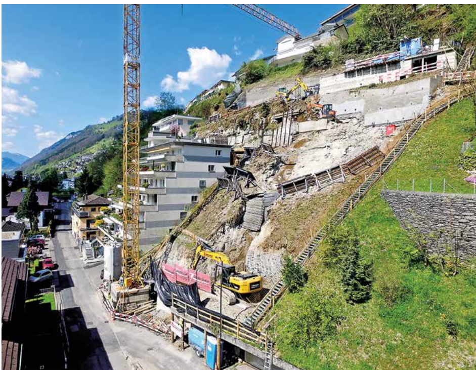
Seitenansicht der Baugrube, steile Arbeitsplätze
