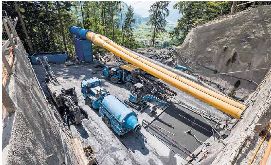
Lademaschine, Fahrmischer und Bohrjumbo beim Voreinschnitt
