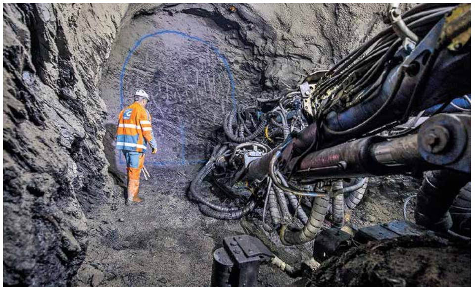
Ausbruchprofil im Rohrstollen
