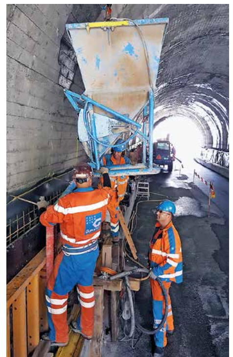
Die Sustenmannschaft beim Betonieren
