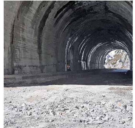
Rückbau des Strassenkörpers
