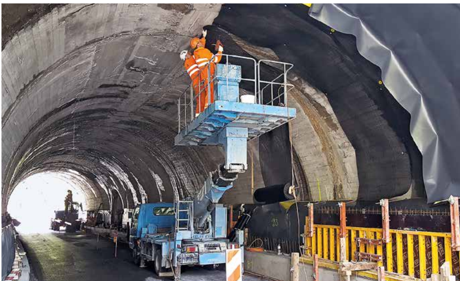
Abdichtungsarbeiten am Tunnelgewölbe
