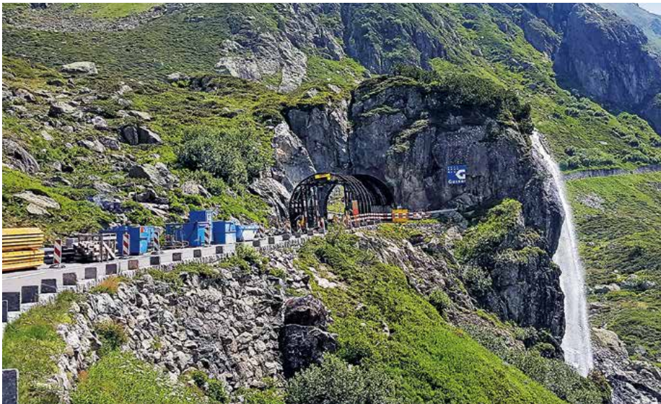
Der Wasserfalltunnel mit dem Schalwagen im Vordergrund
