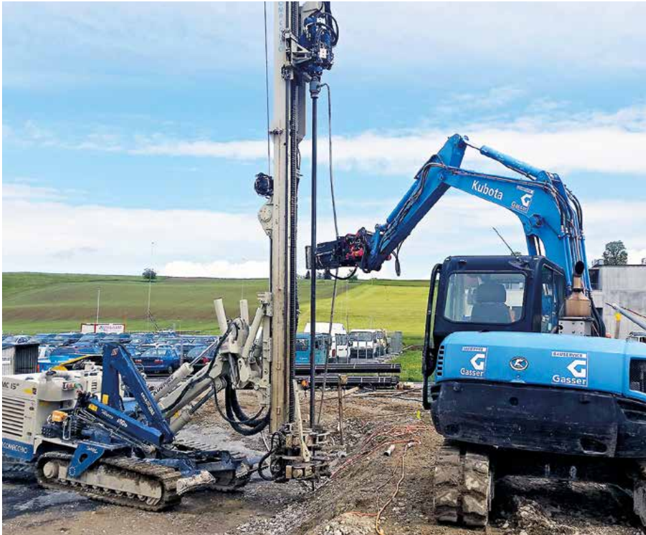
Injektionsbohrpfähle, Einbindung in tragfähige Schichten
