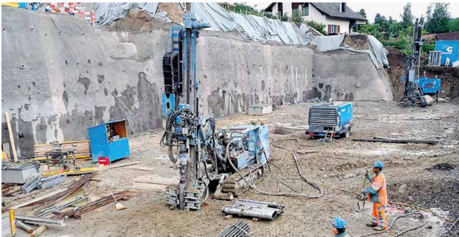
Verrohrte Bohrung für eine neue Wohnüberbauung
