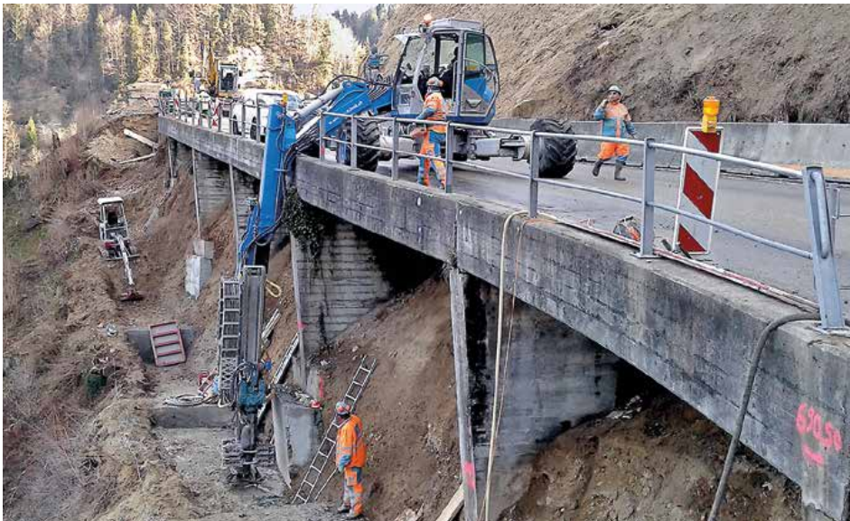
Verrohrte Bohrung mit dem Schreitbagger
