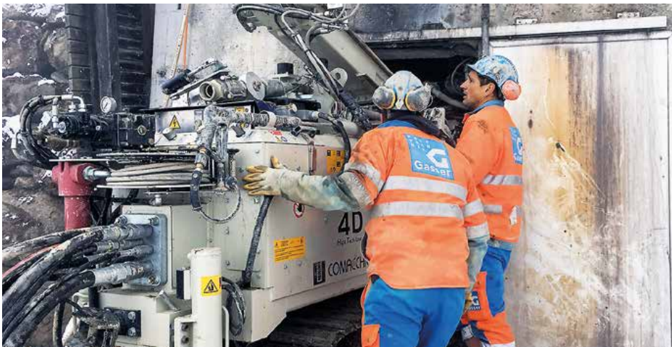
Verrohrte Bohrung mit dem Kellerbohrgerät bei beengten Platzverhältnissen
