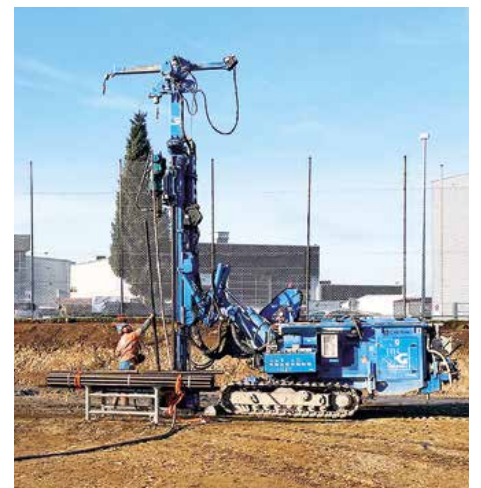
Injektionsbohrpfähle, flexibel einsetzbar
