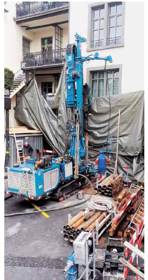
Permanente Pfähle in verrohrten Bohrungen im städtischen Raum
