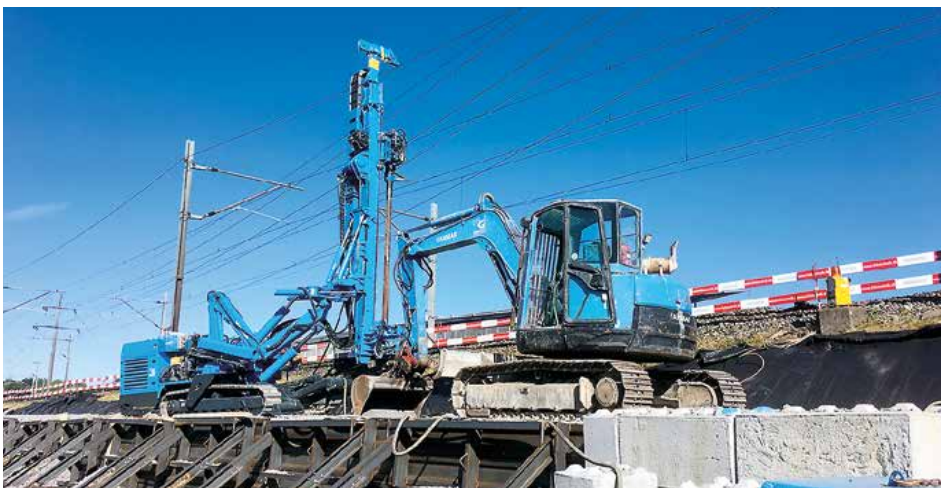
Verdrängungsbohrung mit verlorener Pfahlspitze
