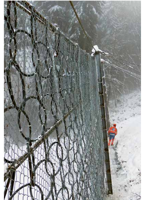
Fertig montierte 5'000 KJ Steinschlagnetze
