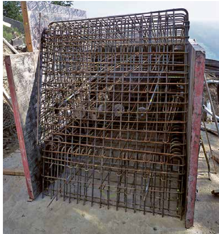
Bewehrung und Schalung des Aufsatzes der Mastenfundation
