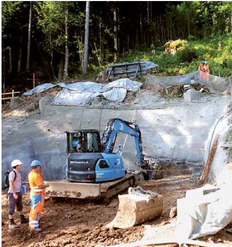
Baugrubensicherung und Bodenstabilisierung für das Mastenfundament 1
