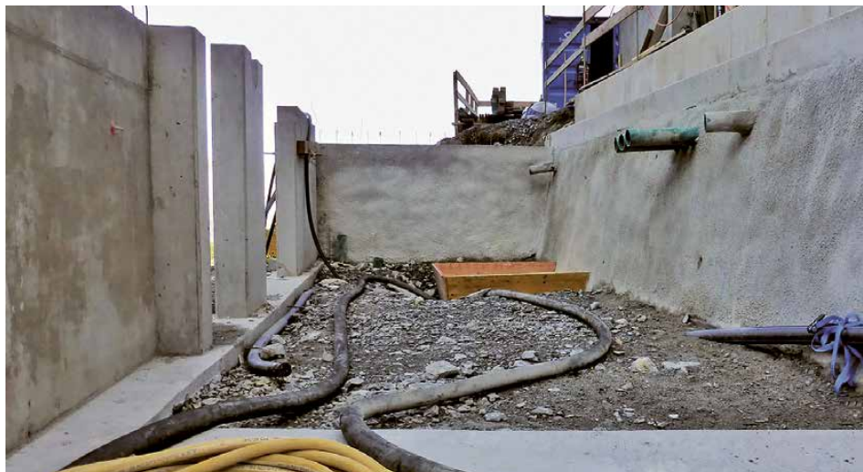
Foundation mit Baugrubensicherung auf abgestuftem Niveau
