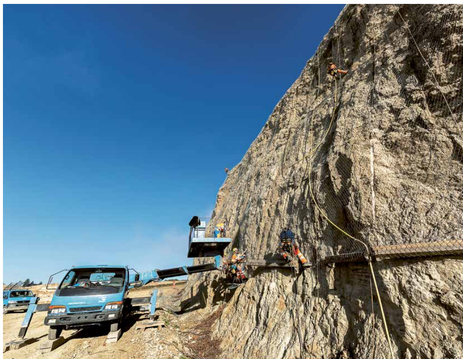
Montage de la terminaison inférieure du treillis
