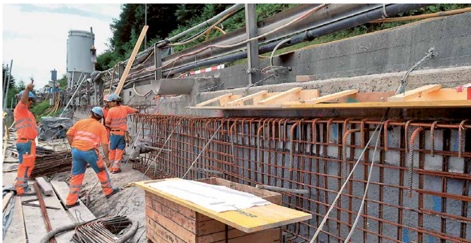
Der bewehrte Stützriegel ist bereit zum Ausspritzen
