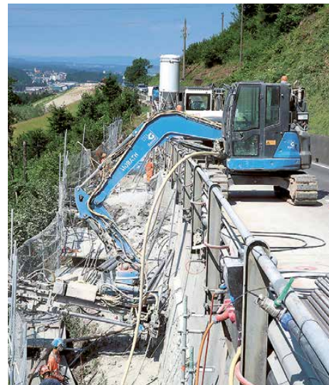
Bohrarbeiten mit dem Bohrbagger von der Strasse
