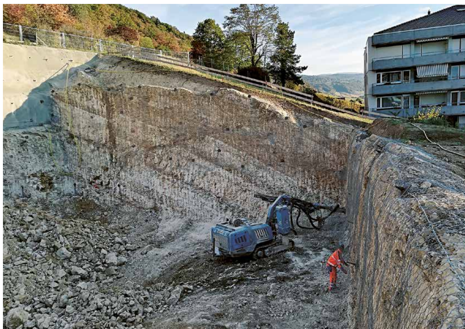
Fouille profonde pour les trois sous-sols
