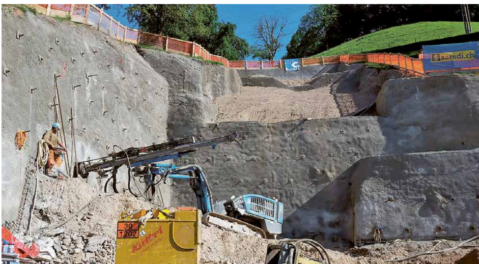
Bohrarbeiten mit dem Sandvik Dino DC 400
