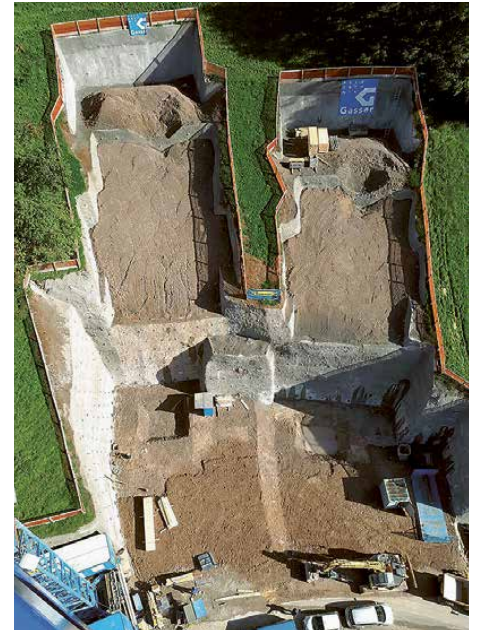
Die Baugrube aus der Vogelperspektive
