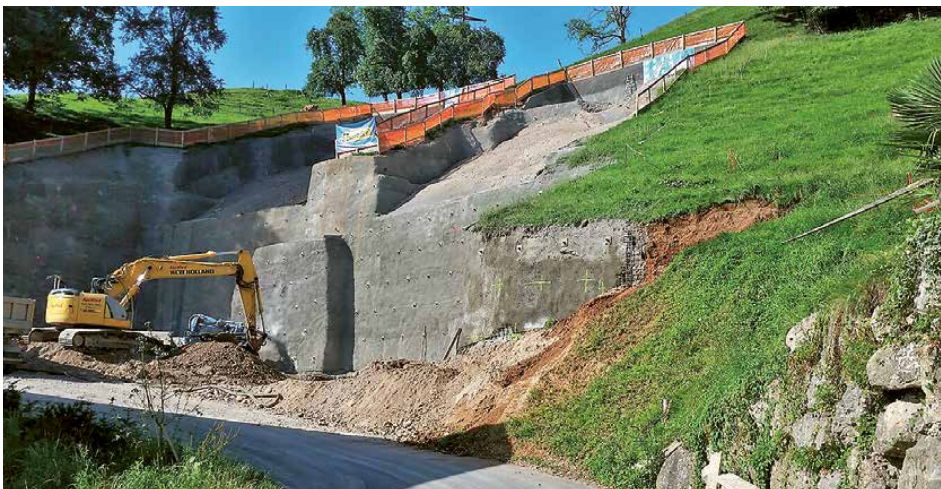
Baugrube mit dem Hinterfüllungsmaterial auf den Bermen
