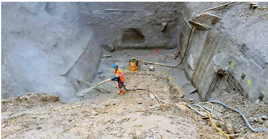
Gunitarbeiten im Startschacht
