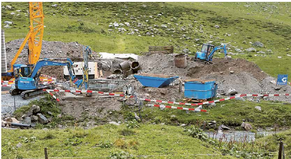
Blick auf den Bauplatz rund um den Schieberschacht
