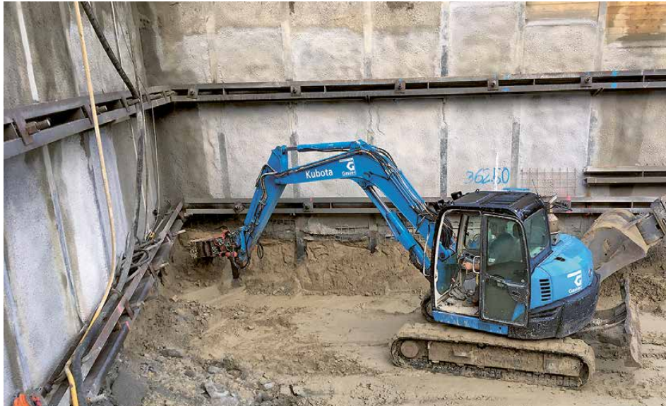
Ankerarbeiten zwischen den HEM-Profilen
