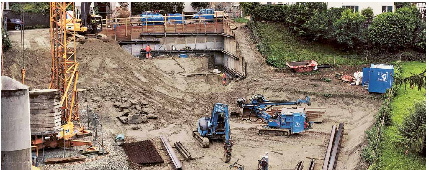
Blick in die Baugrube während den Aushub- und Rühlwandarbeiten
