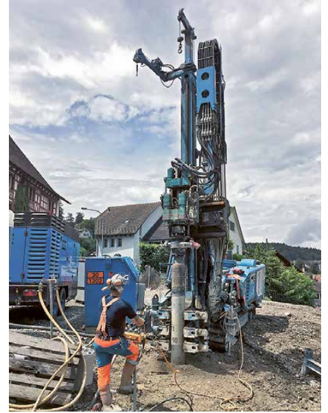
Bohrarbeiten der Rühlwandträger
