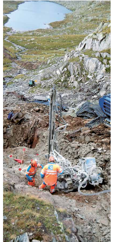
Werkleitungsgraben im steilen Gelände, Bohrgerät Roc 203 mit Winde
