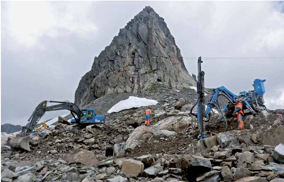
Erstellung der Baugrube für die neue Bergstation Schneehüenerstock
