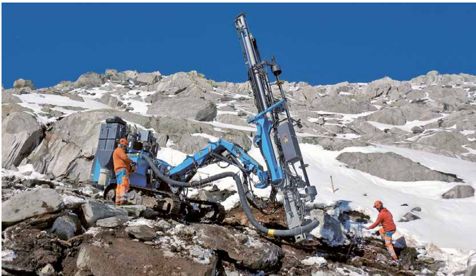
Bohr- und Sprengarbeiten für die neue Skipiste nach Oberalppass
