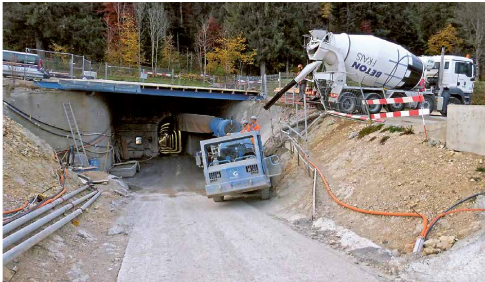
Betonumschlag beim Portal Nord
