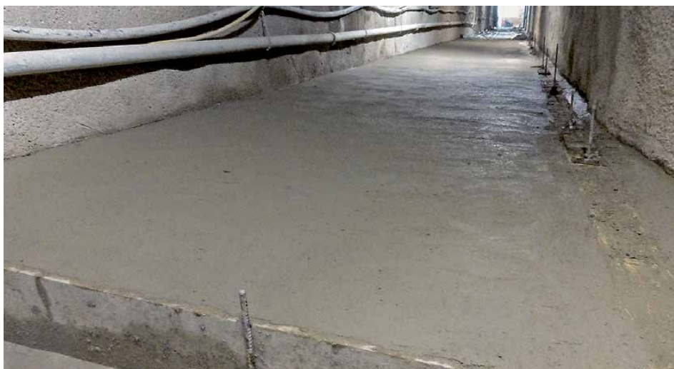
Fertig erstellte Betonsohle
