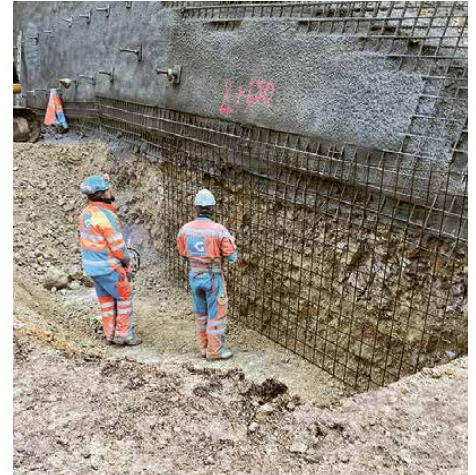
Baugrubensicherung beim Portal Süd
