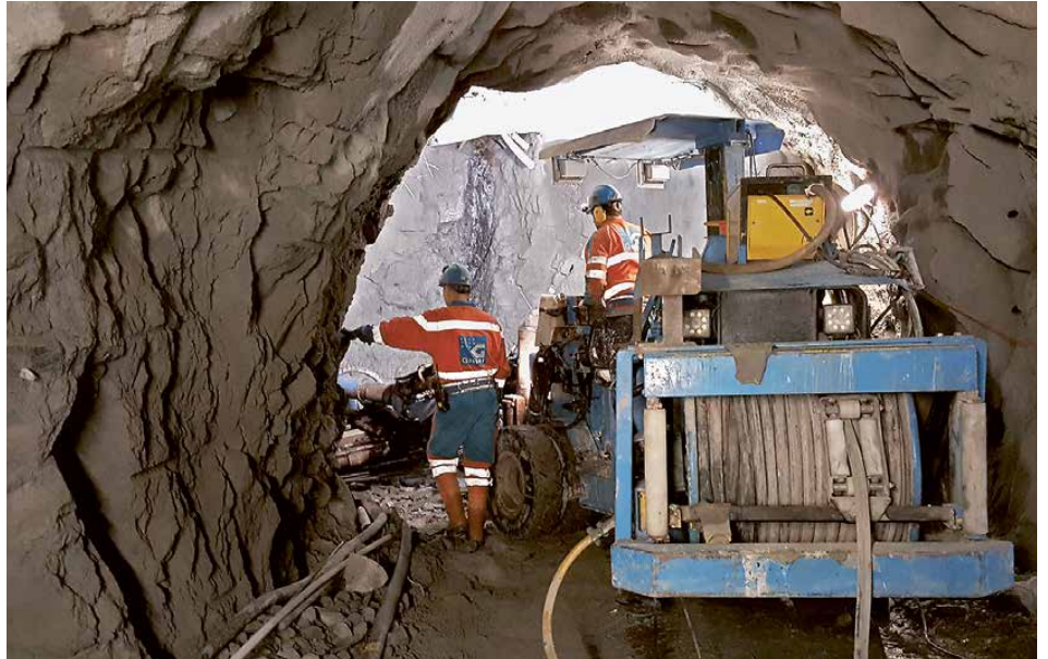
Bohrarbeiten am Verbindungsstollen
