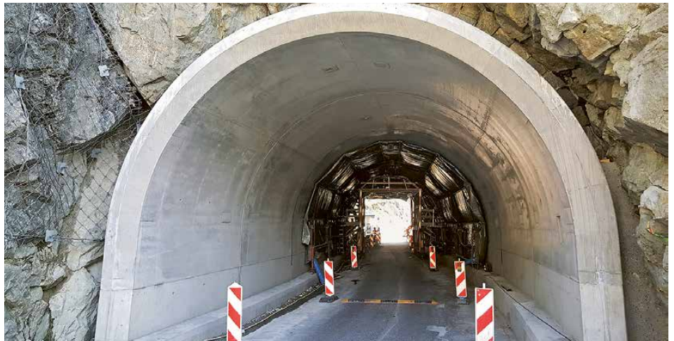
Portal des Wasserfalltunnels
