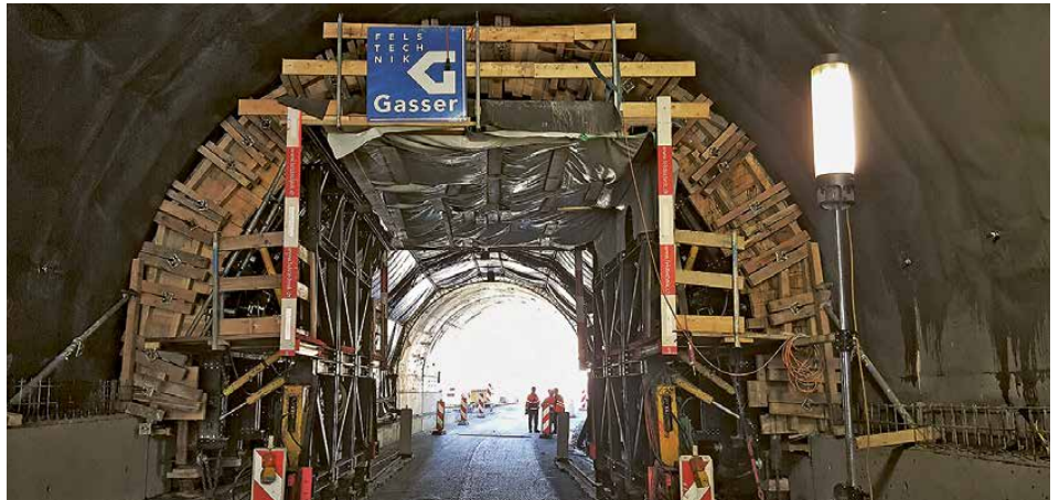
Stirnabschalung am Gewölbeschalwagen
