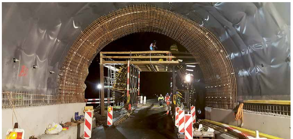
Bewehrung am Tunnelportal
