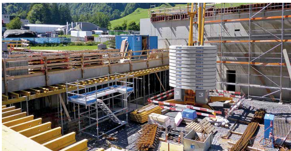
Hochbauarbeiten an der Halle mit Galerie
