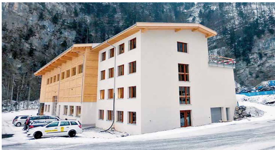
Fertige Lagerhalle mit angeschlossenem Bürotrakt
