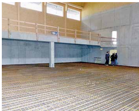
Nachträglich erstellter fugenloser Betonboden
