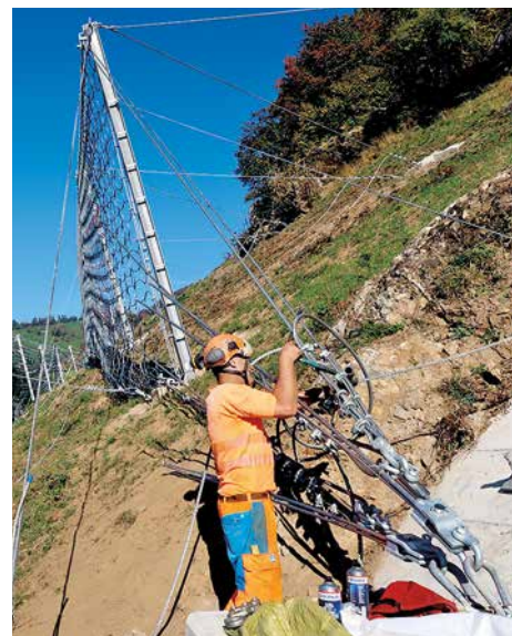
Endmontage des 2000-kJ-Schutzwerkes
