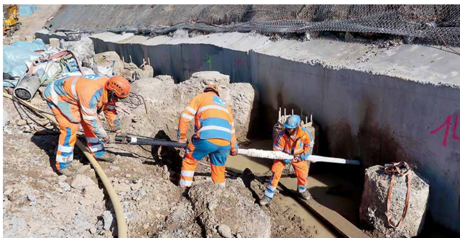
Versetzen eines vorinjizierten Ankers
