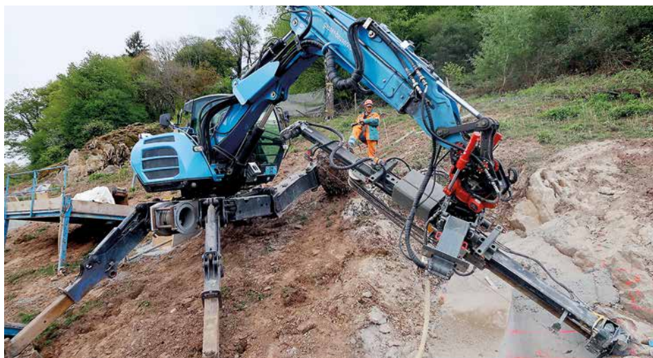
Bohrarbeiten mit dem Schreitbagger
