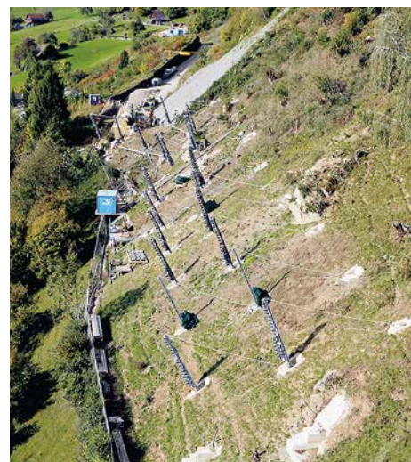
2 x 2'000-kJ-Schutzwerke nach der Helimontage
