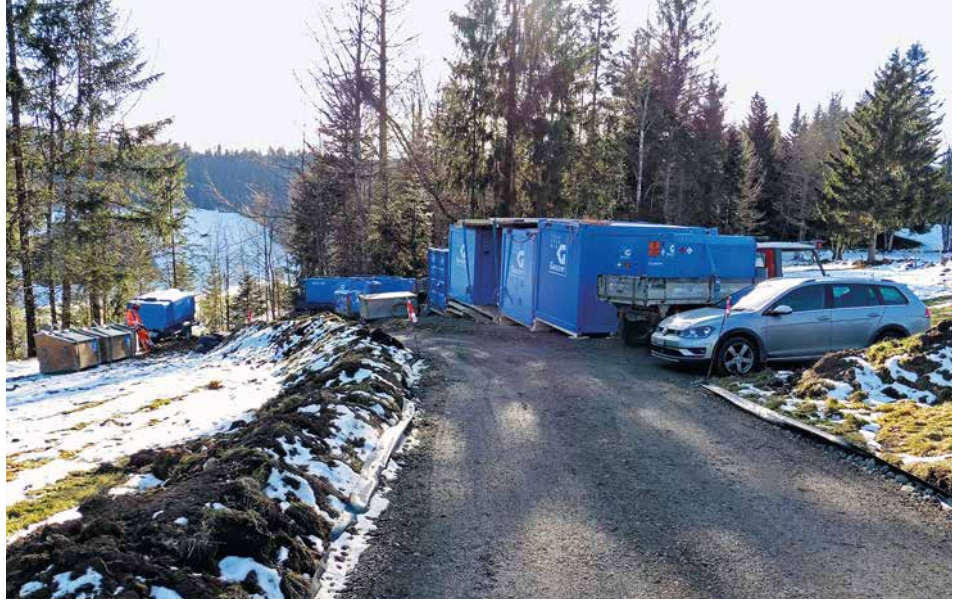
Installation de chantier
