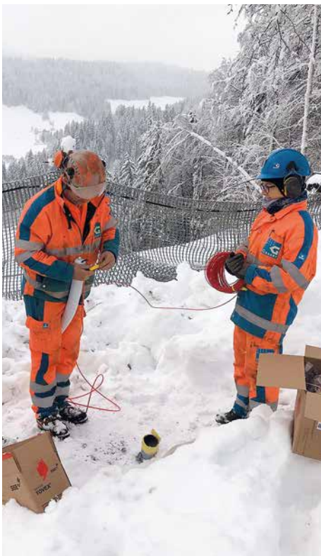
Travaux de chargement
