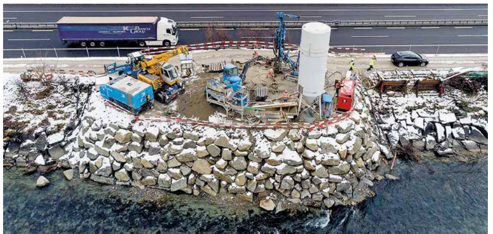
Knappe Platzverhältnisse an exponierter Lage
