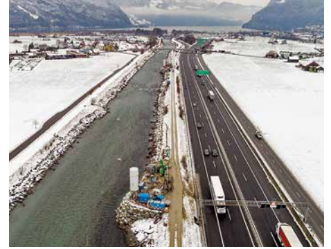
Mastfundamente 9 und 10 auf dem Reussdamm
