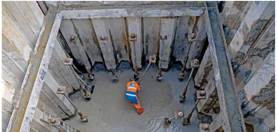
Fertig montierte Pfahlköpfe
