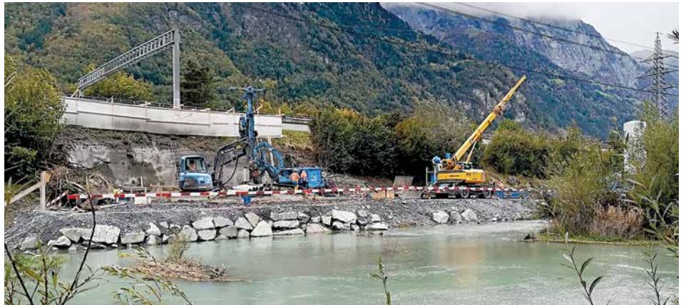
Mastfundament 3 an der stillen Reuss
