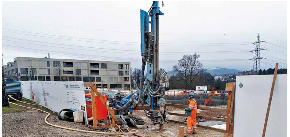
Comacchio ML600 bohrt für Kranpfähle
