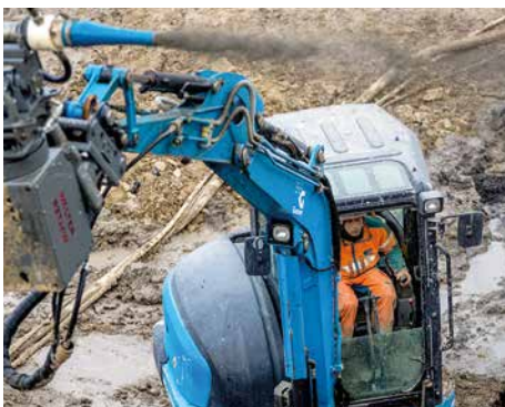
Baugrubensicherung mit Nassspritzbeton
