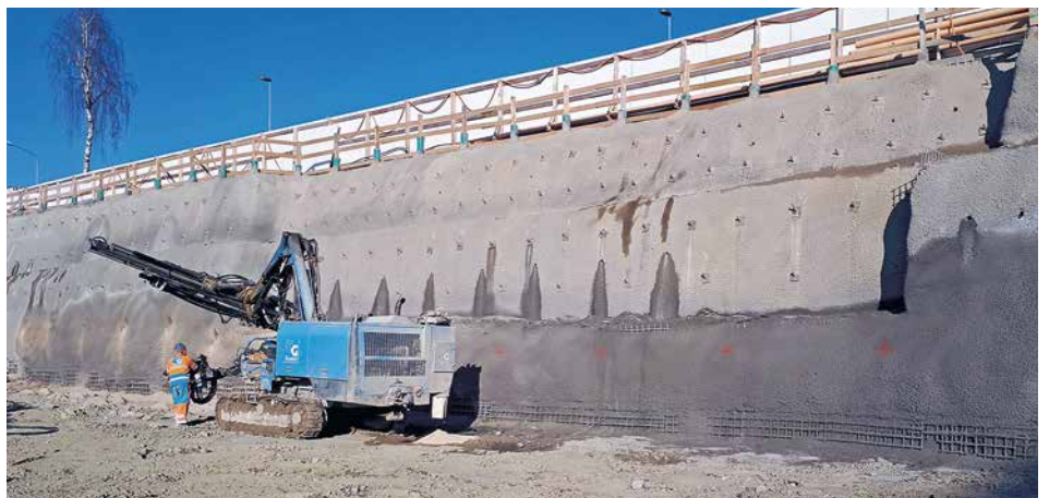
Bohren der Anker mit einem Atlas Copco ROC D5
