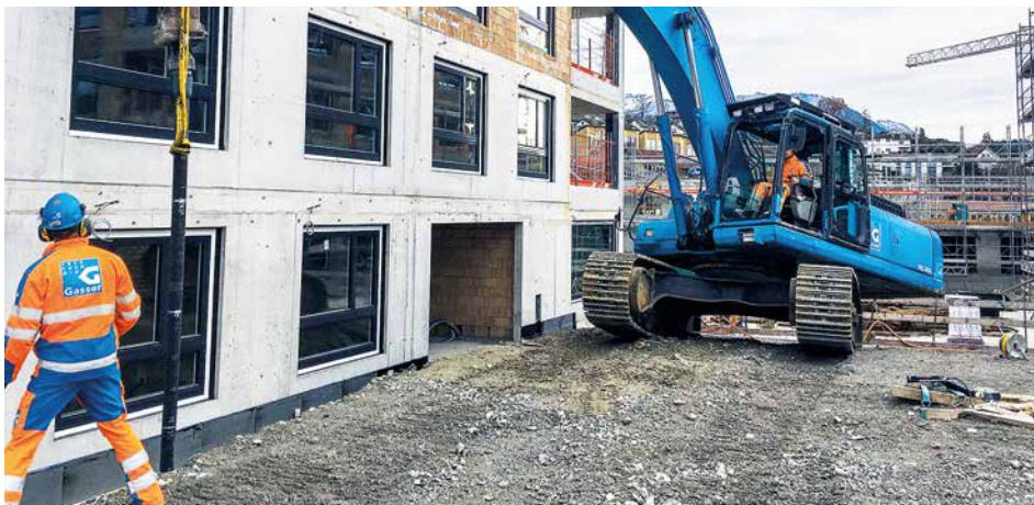
Einbringen des Ramppfahls mittels Vibrohammer
