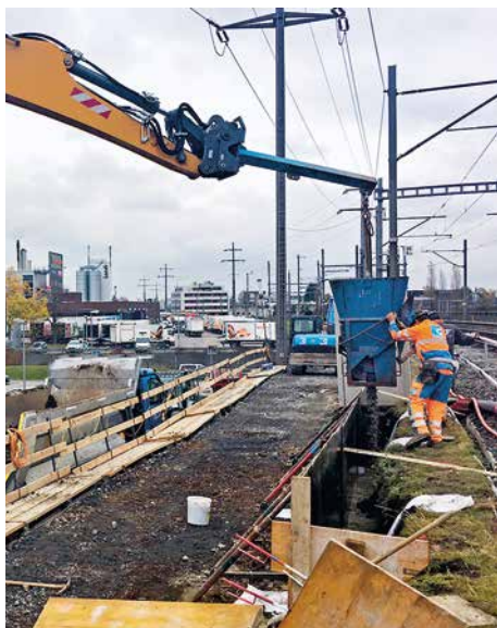
Einbringen des Magerbetons
