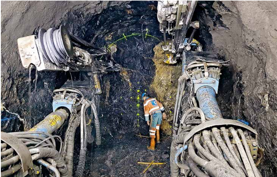
Vortrieb des Rohrstollens mit zweiarmigem Jumbo
