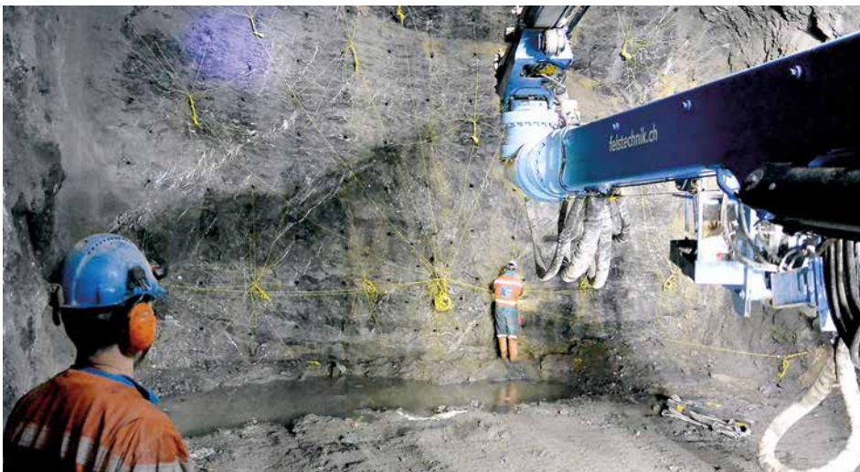
Ladearbeiten im Erschliessungsstollen (ERS)
