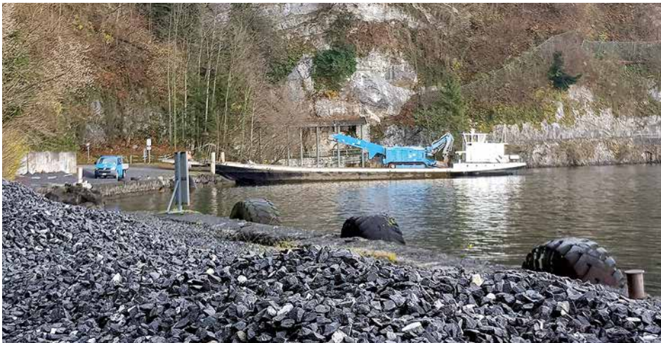
Ankunft der Tunnel-Lademaschine in Kehrsiten
