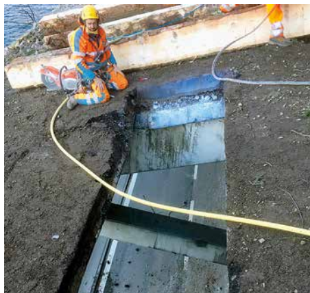
Samstag, 15.30 Uhr: Abbruch des Deckenelements
