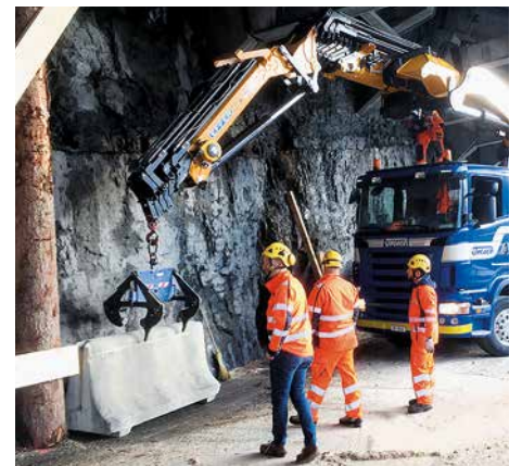
Sonntag, 15 Uhr: Montage New Jersey-Elemente
