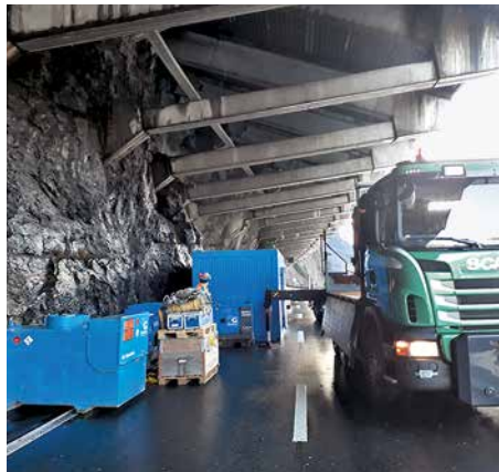
Freitag, 13.30 Uhr: Installationsbeginn
