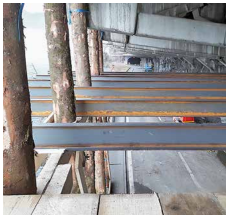
Sonntag, 11.30 Uhr: Montage des Zwischenbodens
