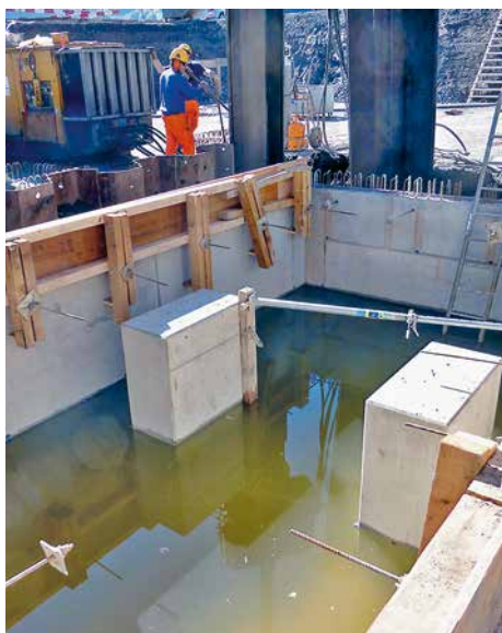
Wasser in der Liftgrube sorgt beim Ziehen der Spundwände für Gegendruck zum Grundwasser
