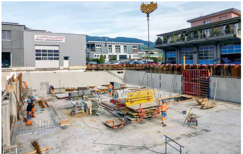
Untergeschoss mit Liftvertiefung
