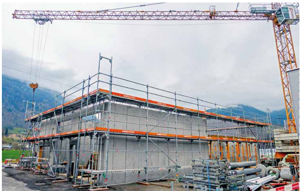
Rohbau der Werkstatt und der Obendreherkran
