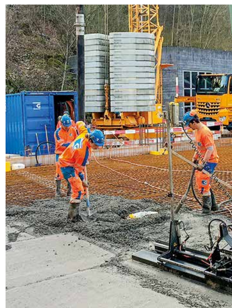
Bodenplatte in Monobeton
