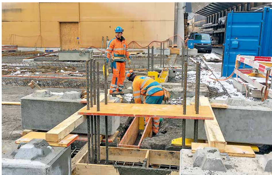
Spezialfundation für die Stützenfundamente
