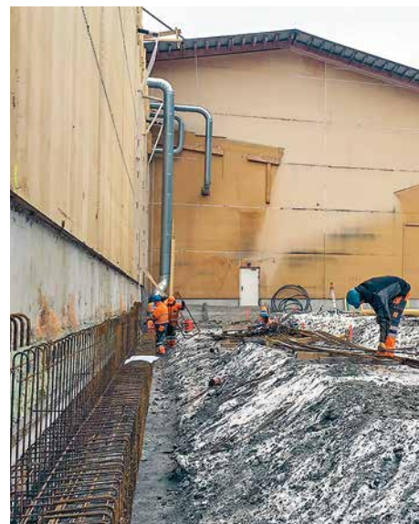
Fundation der Bodenplatte
