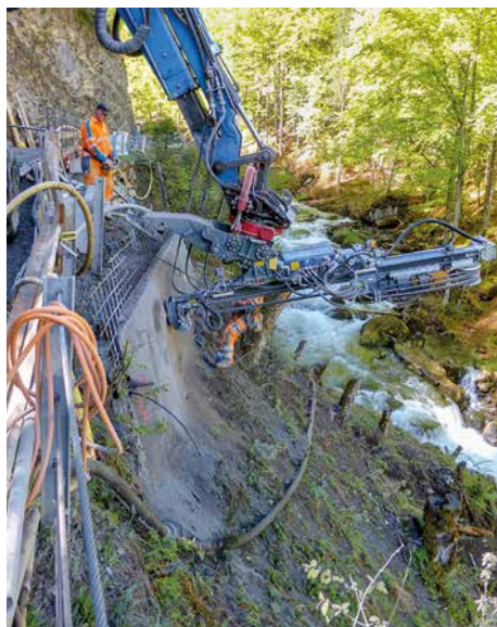
Anker bohren mit dem Schreitbagger
