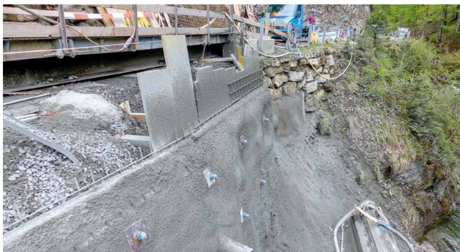
Verankerte Spritzbetonmauer
