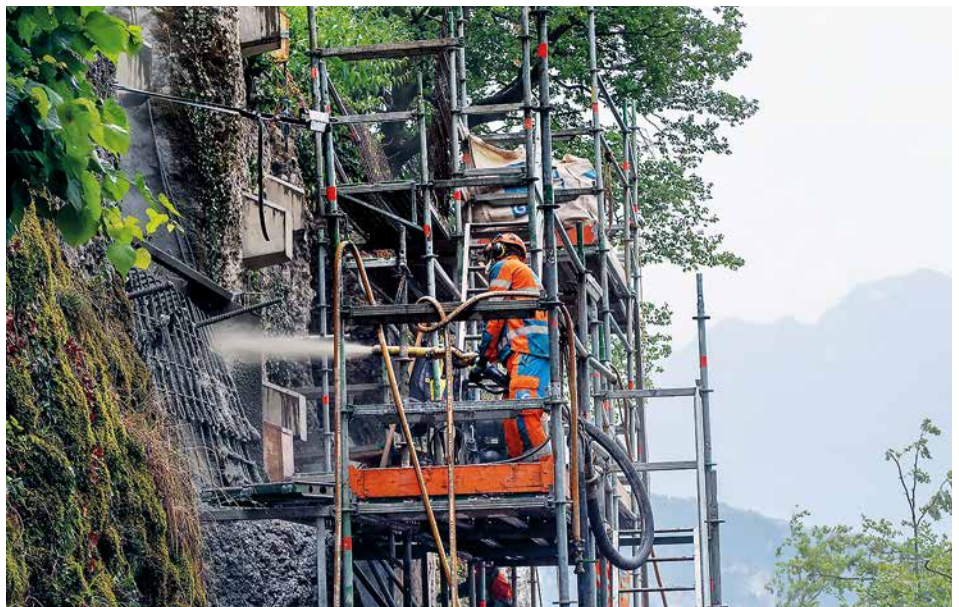
Spritzbetonsicherung und Unterfangung einer instabilen Zone in der Felswand
