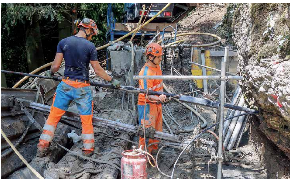
Versetzen eines Ankers und Abdichten eines Ankerstosses mit einem Schrumpfschlauch
