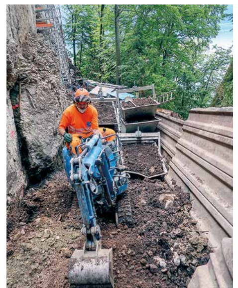
Aufladen des Materials nach dem Felsrückbau
