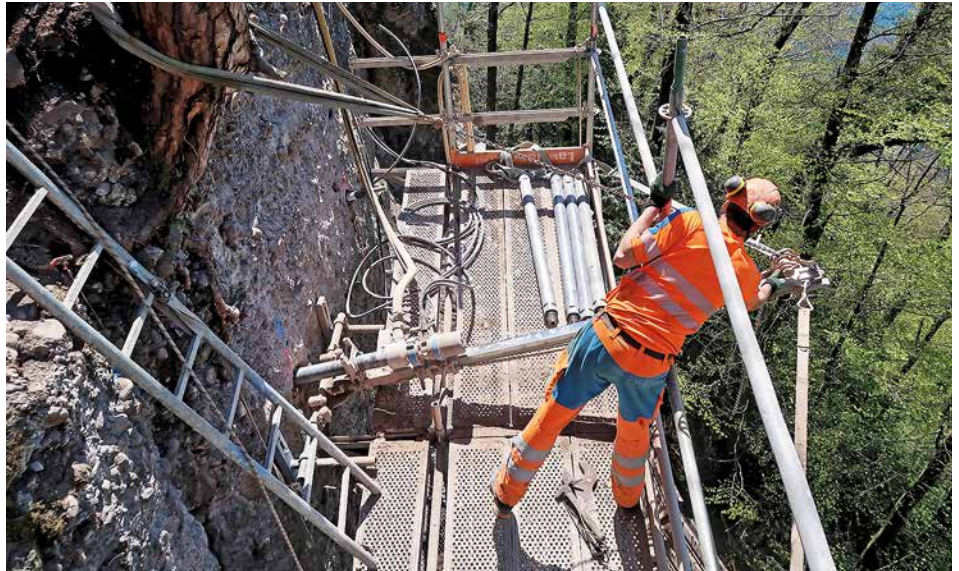
Bohrarbeiten ab dem Gerüst
