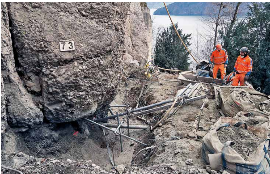
Bohrarbeiten für die Fussverankerung
