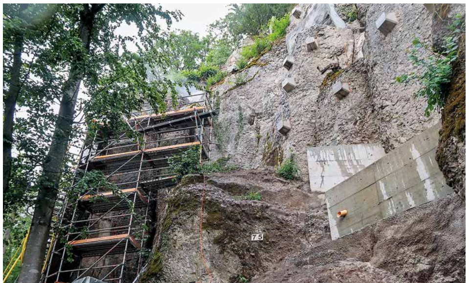
Abgeschlossener Bereich mit Betonplomben und vor Korrosion geschützten Ankerköpfen
