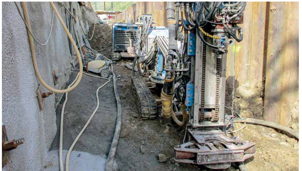
Äusserst knappe Platzverhältnisse hinter der Spundwand
