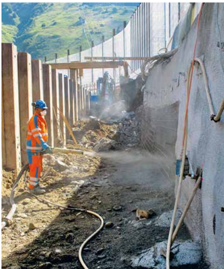
Spritzbetonarbeiten
