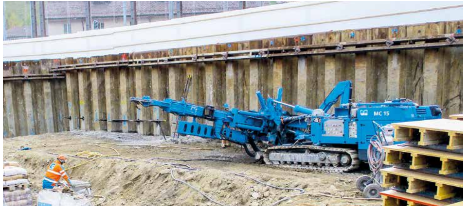
Injektionsarbeiten bei der 1. Etappe
