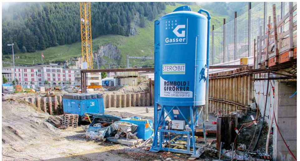
Installationsplatz für die 2. Etappe
