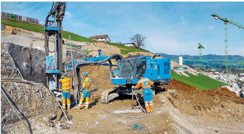
Bohren der Verankerung mittels Sandvik DX 700
