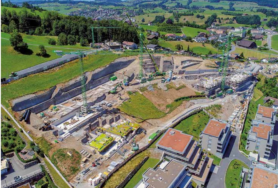
Beginn des Hochbaus in den sicheren Baugruben
