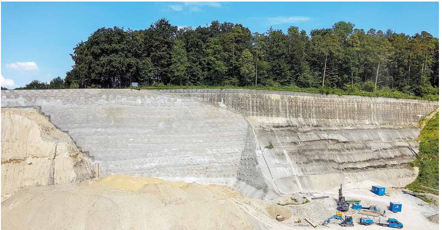
Die gesicherte Grubenwand
