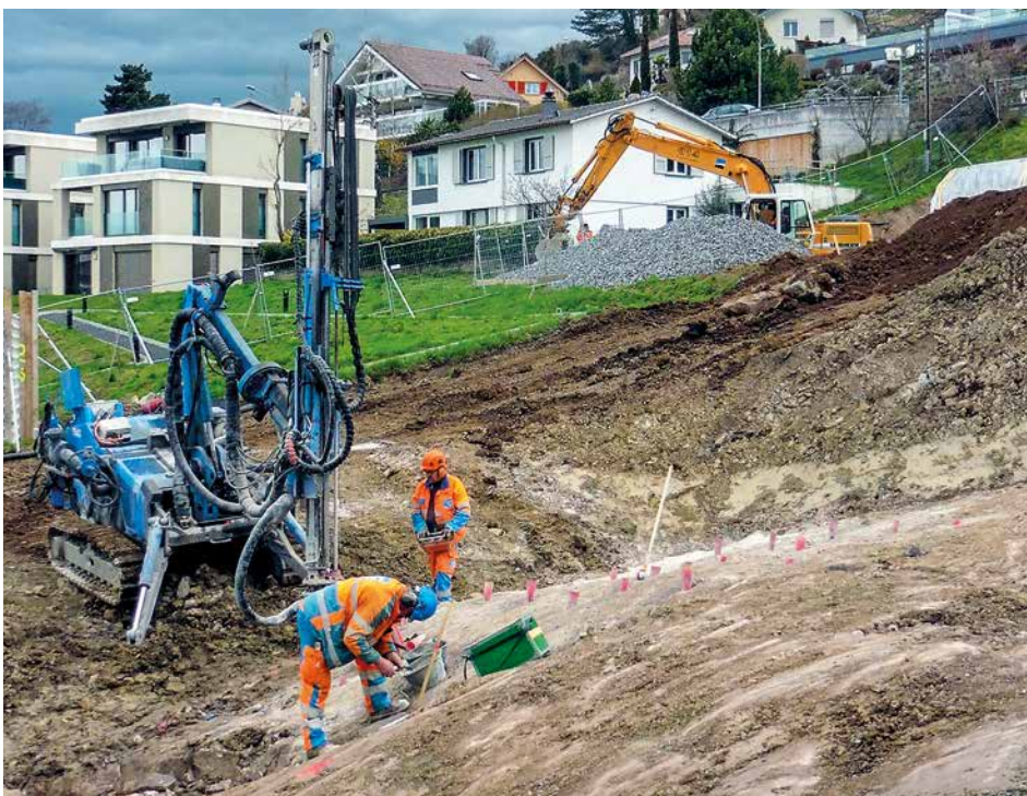
Bohr- und Ladearbeiten
