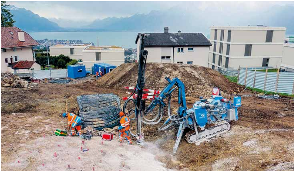
Emissionsarmer, sprengtechnischer Felsabtrag inmitten von Wohnhäusern
