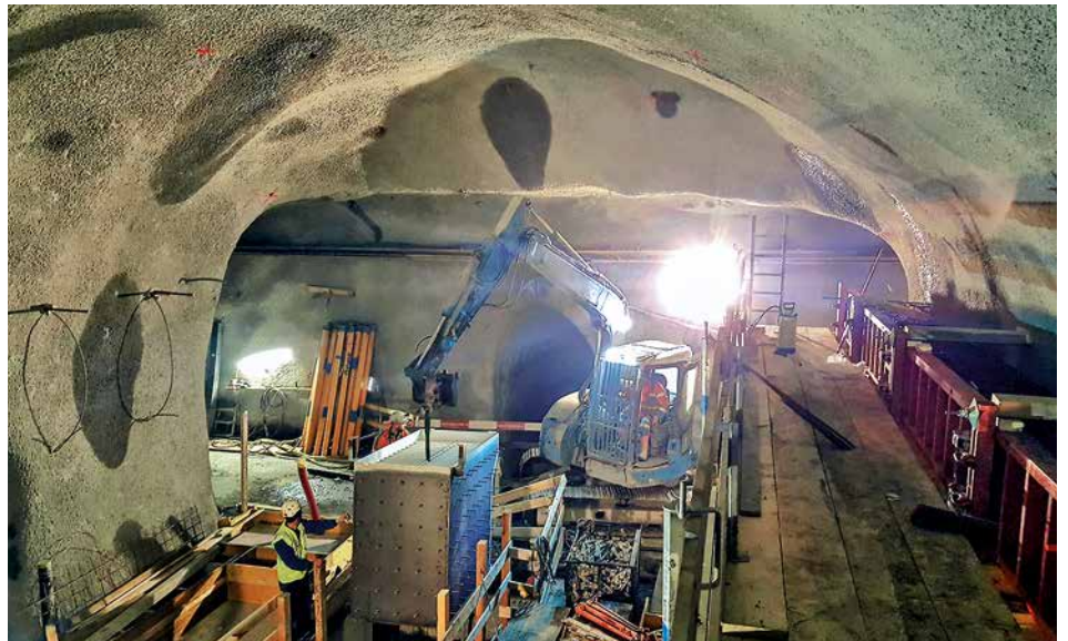
Die Kranbahn vor dem Betonieren
