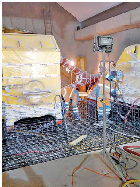
Montagearbeiten in der Kaverne
