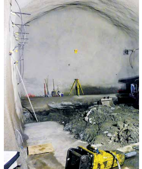
Verankerungen für die zu erstellende Kranbahn
