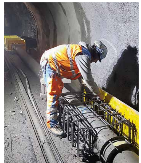
Schalung der Betonaufleger
