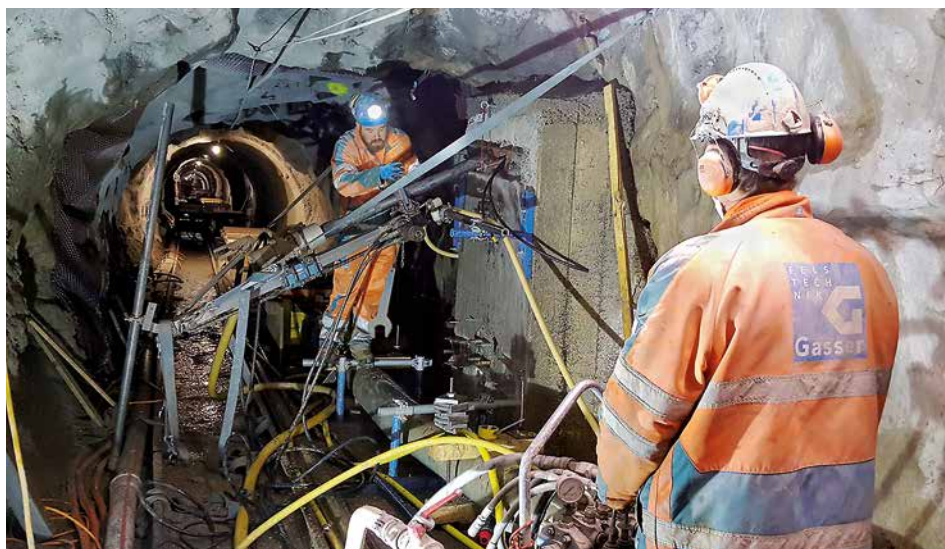
Bohrarbeiten am Fixpunkt 1
