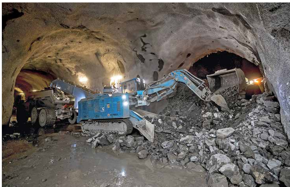
Im Verladestollen wird geschuttert
