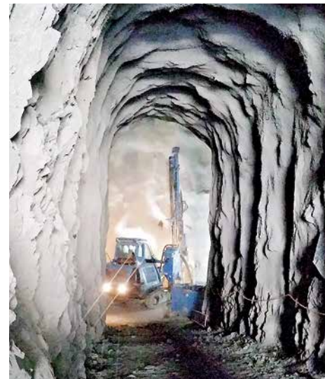
Tieflochhammer-Bohrgerät im Speicherkopf
