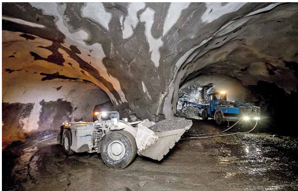
Bohrarbeiten in der Kaverne
