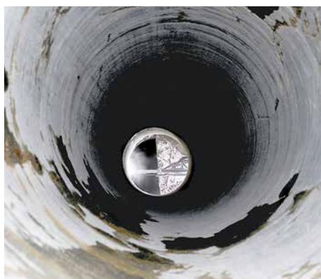
Speicherkopf, von oben durch die Raise-Bohrung
